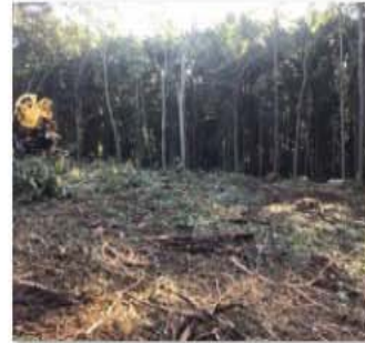
Photo 4 - WTP Site Clearing.jpg
