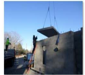
Setting precast planks.JPG
