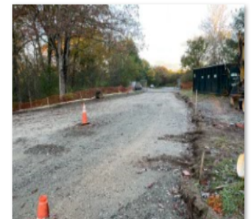
11.01.21 WTP Access Road.jpg
