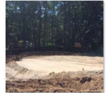
Site Grading - WTP.JPG
