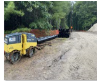
10.4.21 WTP Site (2).jpg
