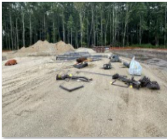
10.4.21 WTP Site (1).jpg
