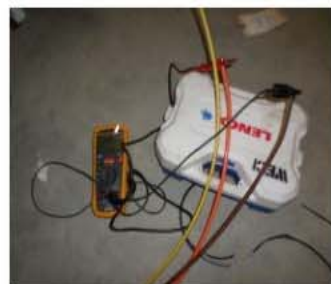
Mega Testing cables.JPG
